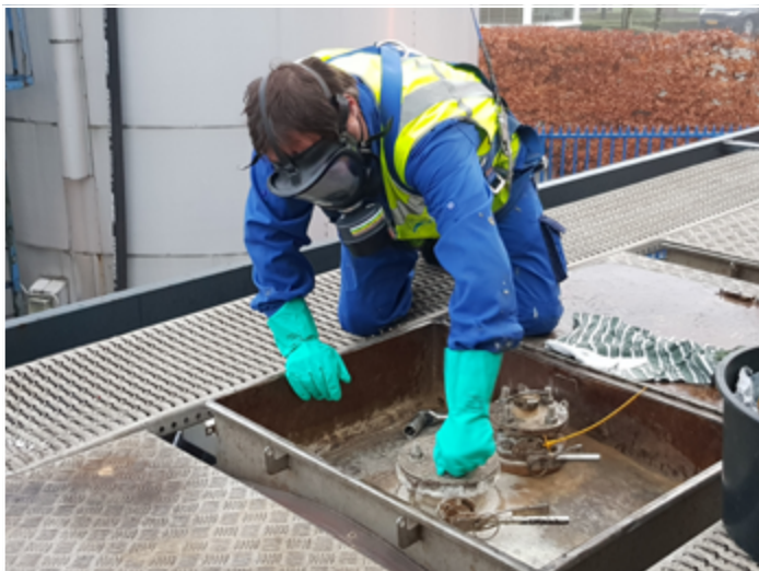
Aansluiten TDI tankwagens om te lossen (© Draka Interfoam)
